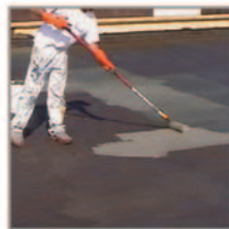
Terrazas y Cubiertas
