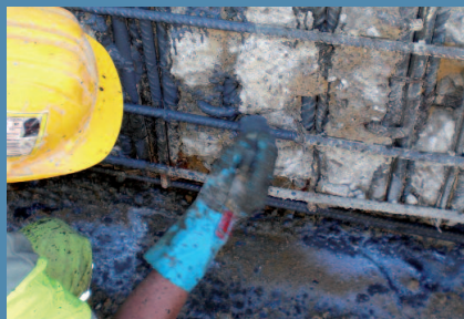
Imprimación - pasivado armaduras
