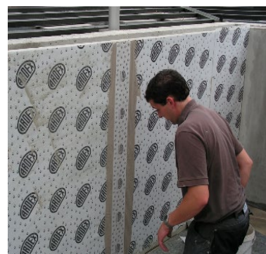
Instalación de ARDEX SK12
