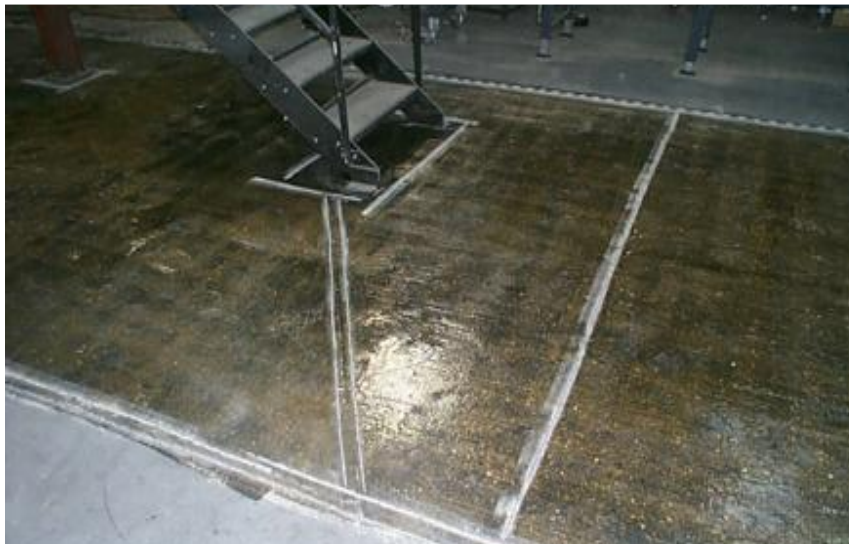
Aspecto de una superficie imprimada y con las rozas de anclaje cortadas.
