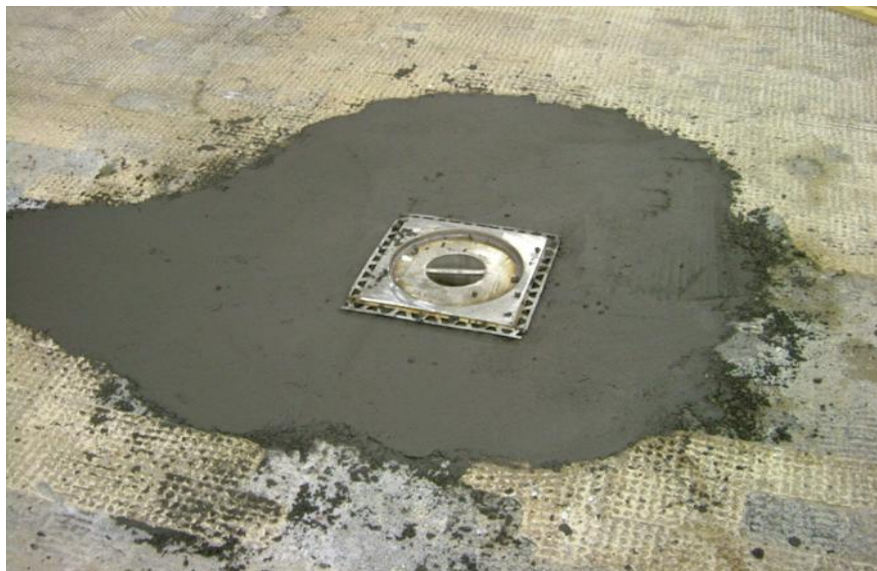
Desagüe colocado en posición usando ARDEX A 45
